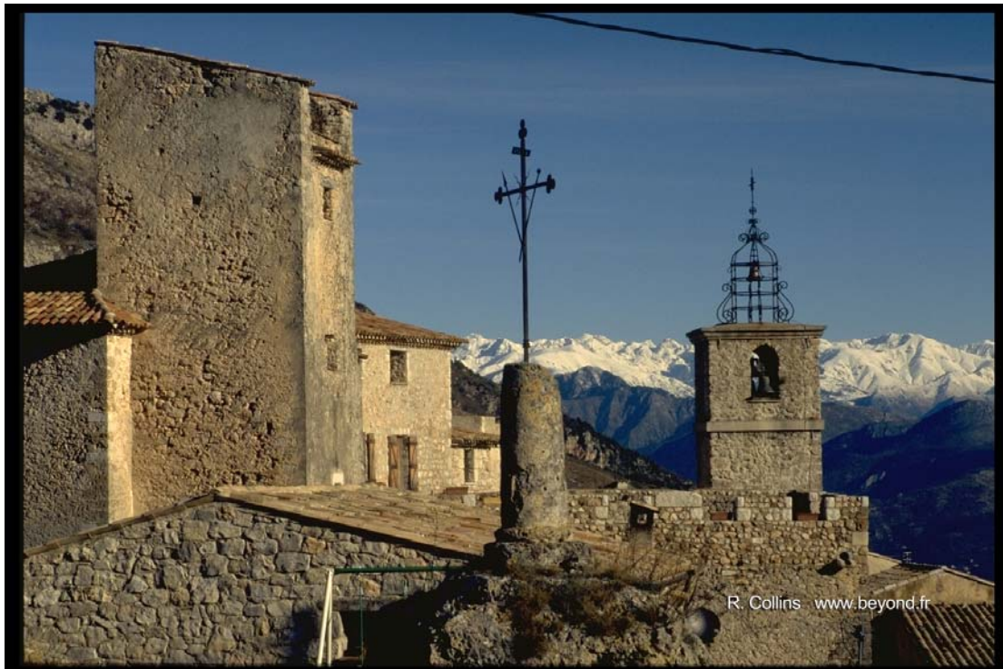
Fig 5. Vieux village de Bézaudun-les-Alpes. Aujourd'hui l'activité de ce centre historique est faible.
